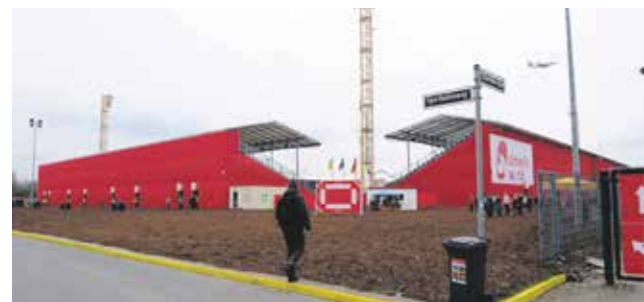
Das mobile Stadion wurde binnen 50 Tagen errichtet.
