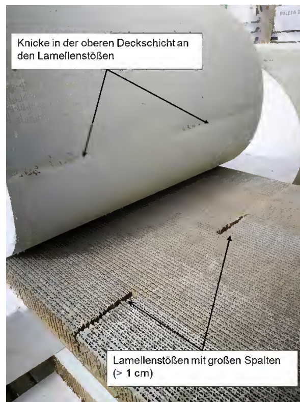
Abbildung 6-32: VR4-T2-3: Oberes Deckblech nach Versuch aufgebogen; Lamellenstöße und Knicke in oberem Deckblech
