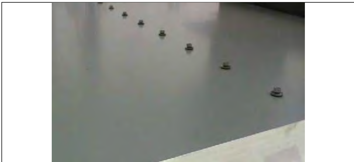
Abbildung 2-103: Direkte Befestigung in Durchsteckmontage [51]
