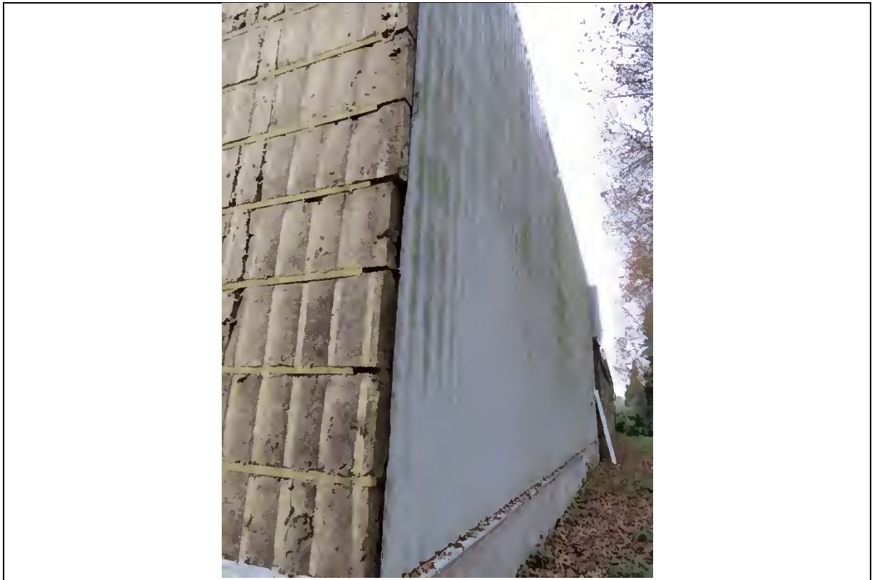
Abbildung 4-223: Fassadenabschnitt vor (rechts) und nach (links) Demontage der Trapez- Außenschale
