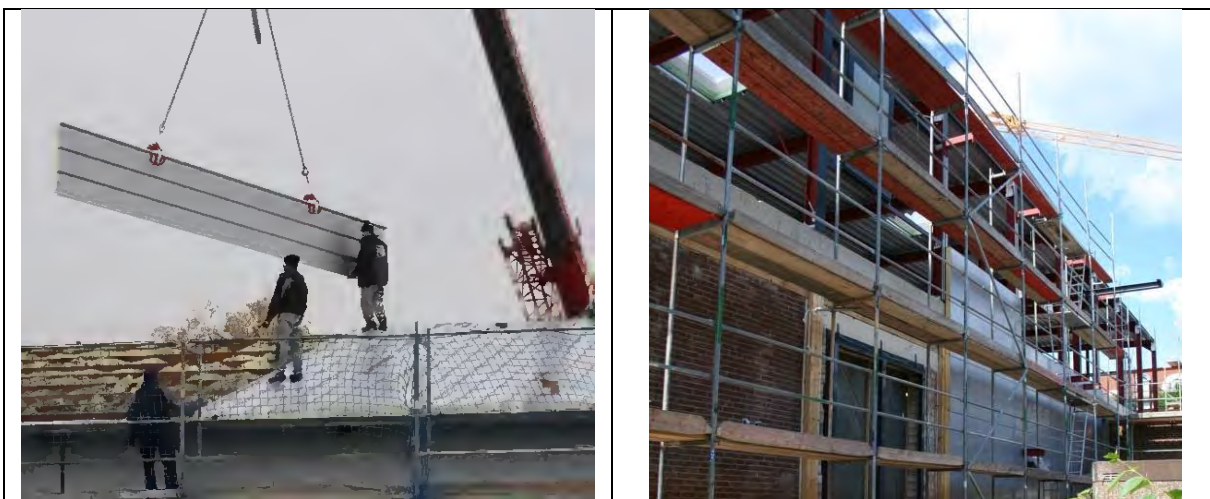
Abbildung 1-5: Praxisbeispiele – Dach- und Fassadensanierung mit Sandwichelementen Figure 1-5: Practical example – Roof and façade refurbishment with sandwich elements
