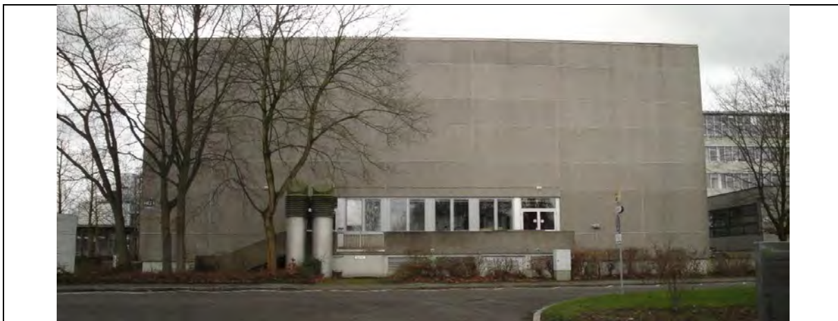
Abbildung 4-66: Beispielgebäude mit massiver Fassade [77]
