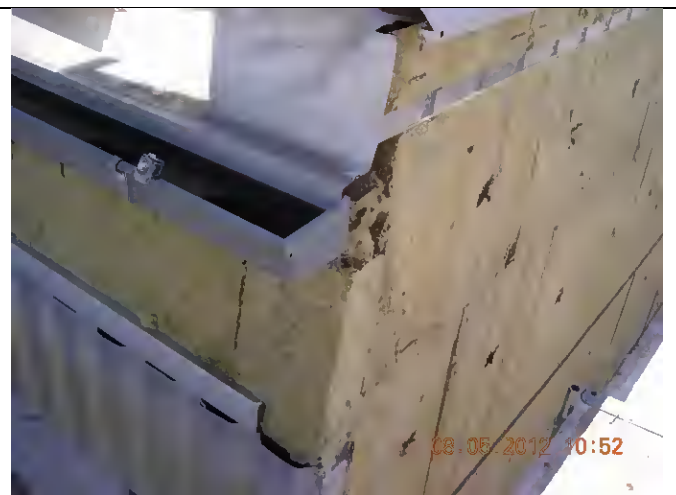
Abbildung 4-236: Detailansicht Unterkonstruktion im Traufbereich zur Montage der Sandwichelemente
