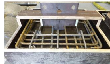
Bewehrungskorb und Schalung:
