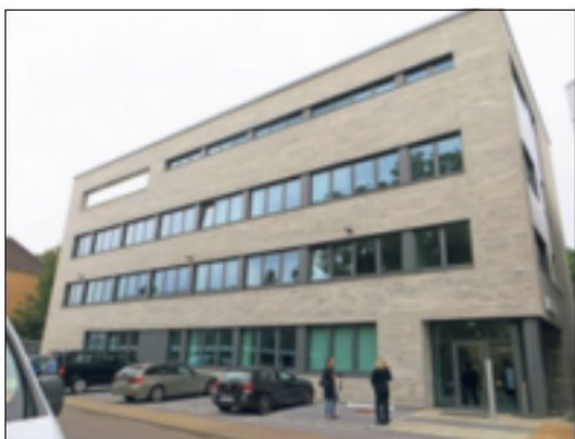
Das neue Dienstgebäude wurde direkt neben dem alten Bau gebaut.
