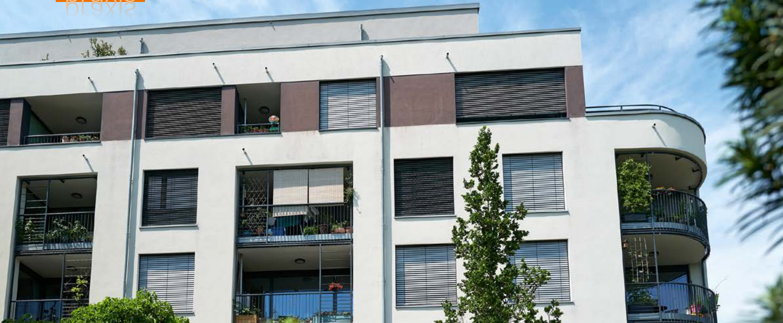
Klimaschutzsiedlung Malerstraße in Wuppertal
