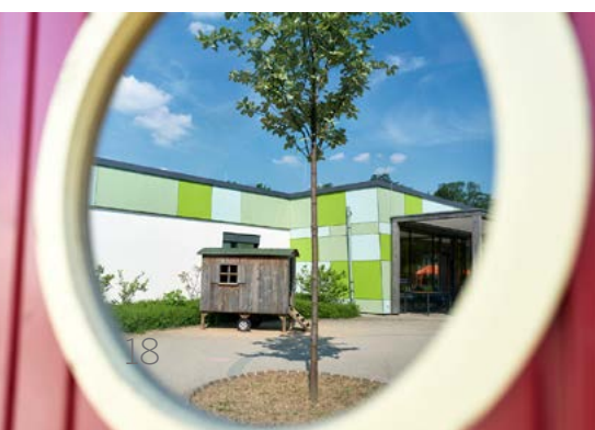
Passivhaus KiTa Spatzennest in Wuppertal
