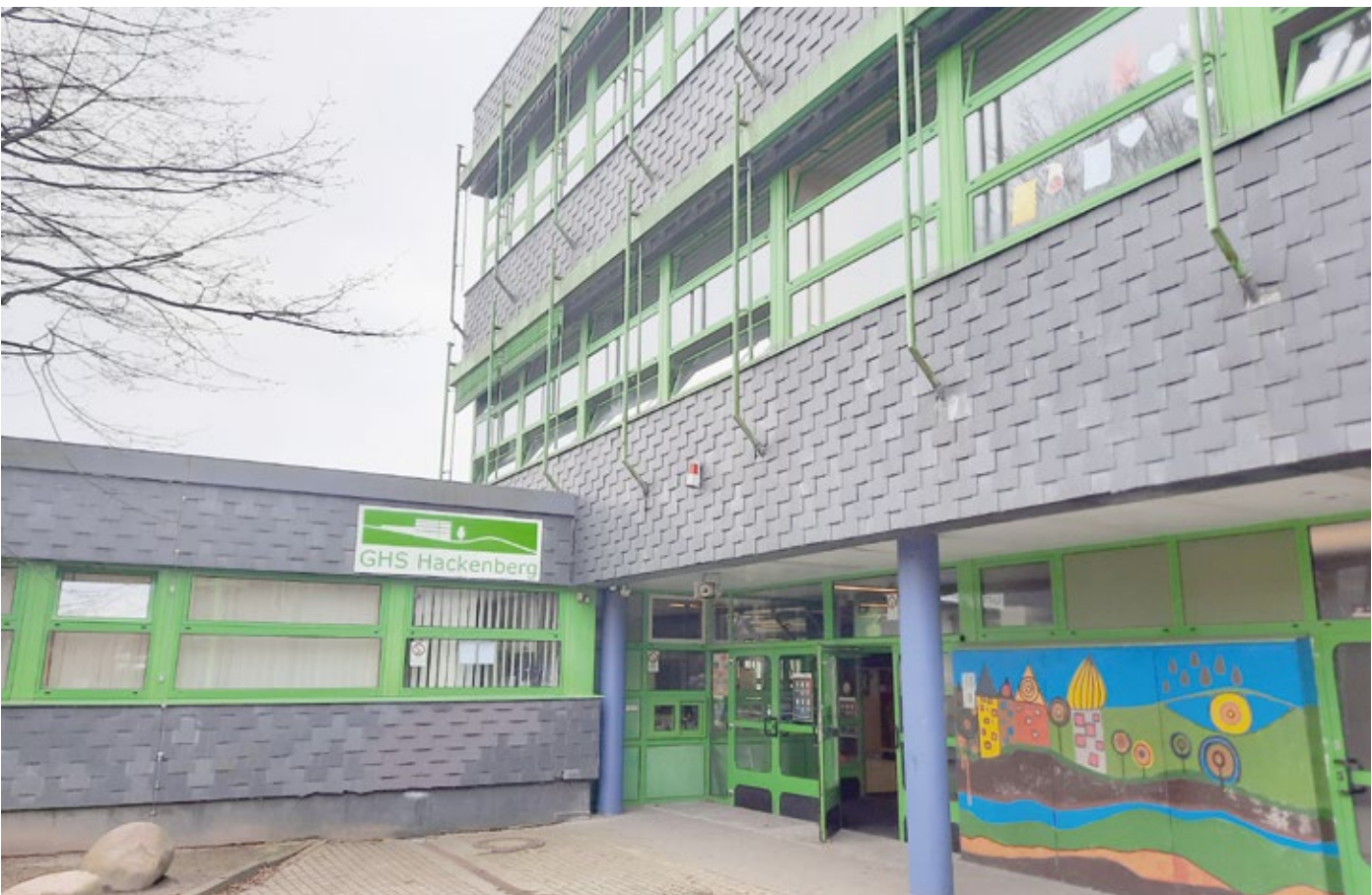
Schule mit Tradition: Das Gebäude am Schulzentrum Hackenberg wird grundlegend saniert und erweitert. Foto: Bona
