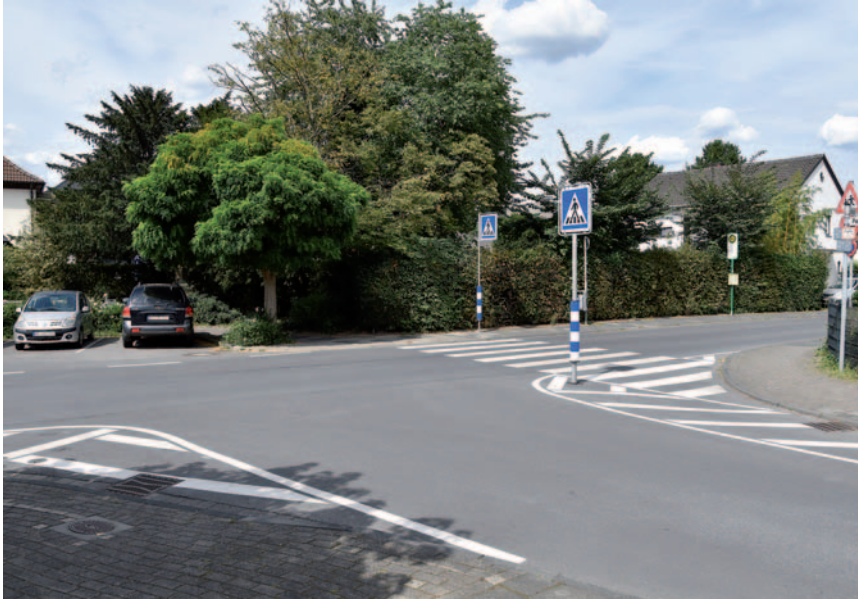
An der Kreuzung von Kirch- und Poststraße verkürzen Markierungen den Weg über die Fahrbahn der Poststraße. Über die Kirchstraße führt ein Zebrastreifen. Foto: Birte Hauke
