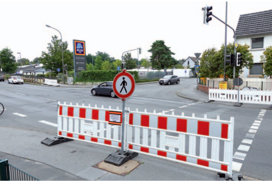
Ausgerechnet zum Dienstbeginn fiel die Ampelanlage am Winkelsweg aus.
