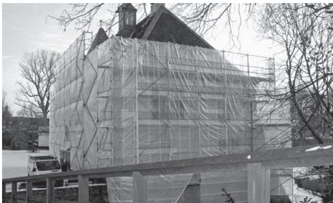
Die Sanierungsarbeiten am Jagdschloss im Museumszentrum Burg Linn haben begonnen.
