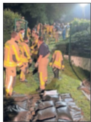
Einsatzkräfte der Feuerwehr bauten einen Wall aus Sandsäcken, um das Albert-Schweitzer-Haus zu schützen. Foto: FW GV
