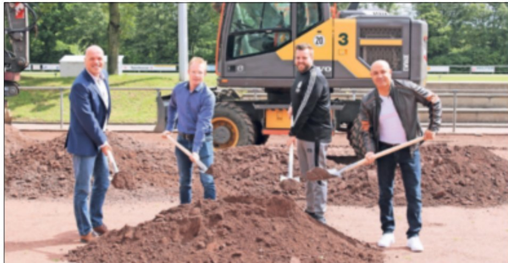
Spatenstich für den Kunstrasenplatz auf der Süd-Anlage: Bürgermeister Klaus Krützen, Planer Jonathan Schneider, FC-Süd-Vertreter Marco Pieper und Sport-Ausschussvorsitzender Ceylan Er. Nach dem Weltuntergangregen der Vortage war für den Spatenstich am Donnerstag Mittag extra die Sonne herausgekommen. Foto: -gpm.
