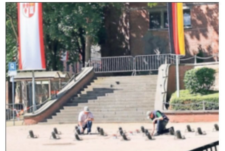
Die so genannten „Katzenköp“ müssen von Fachpersonal gewartet und in Betrieb gesetzt werden.
