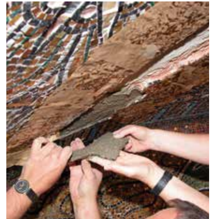
Neusetzen des Mosaikstücks in Mörtel; 2009 (Abb. 9).
