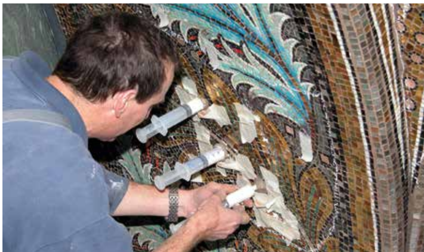
Hinterfüllen der Hohlstellen mit Kalkmilch; 2007 (Abb. 6).
