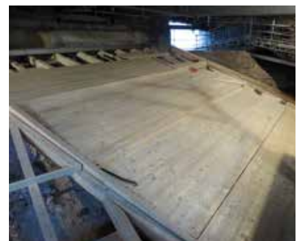
Neue Holzunterkonstruktion: fertig verschraubte Schalung; 2016 (Abb. 4).
