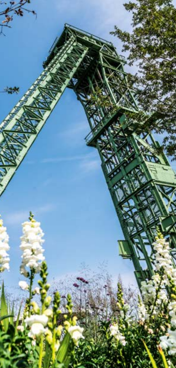
// INDUSTRIEKULTUR IN STAHL: DAS FÖRDERGERÜST DER EHEMALIGEN ZECHENANLAGE ÜBER SCHACHT 2.
