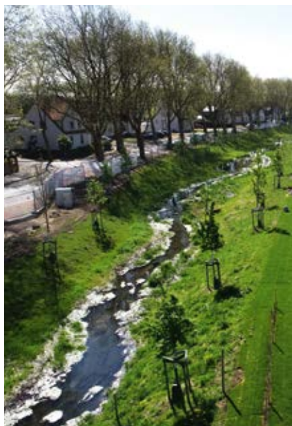
// NATURNAHER AUSBAU DER GROSSEN GORLEY IN KAMP-LINTFORT.
