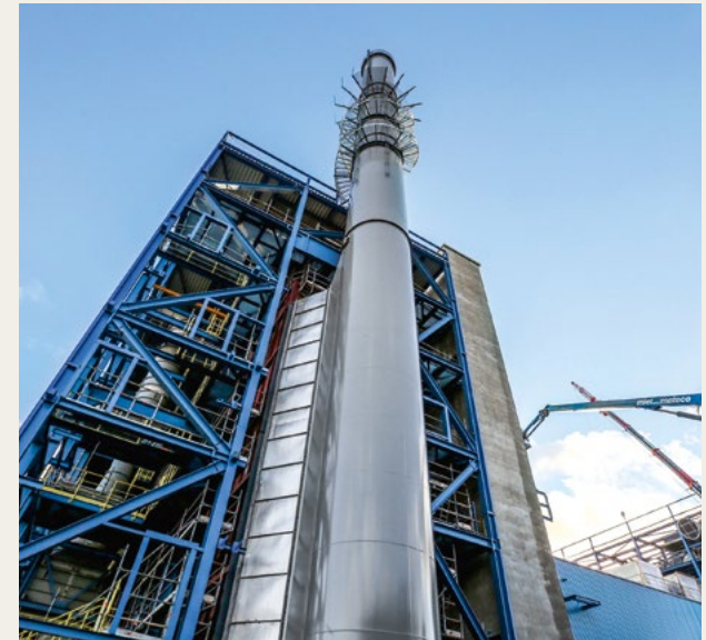
Bau der neuen GuD-Kraftwerke am Standort Marl.
