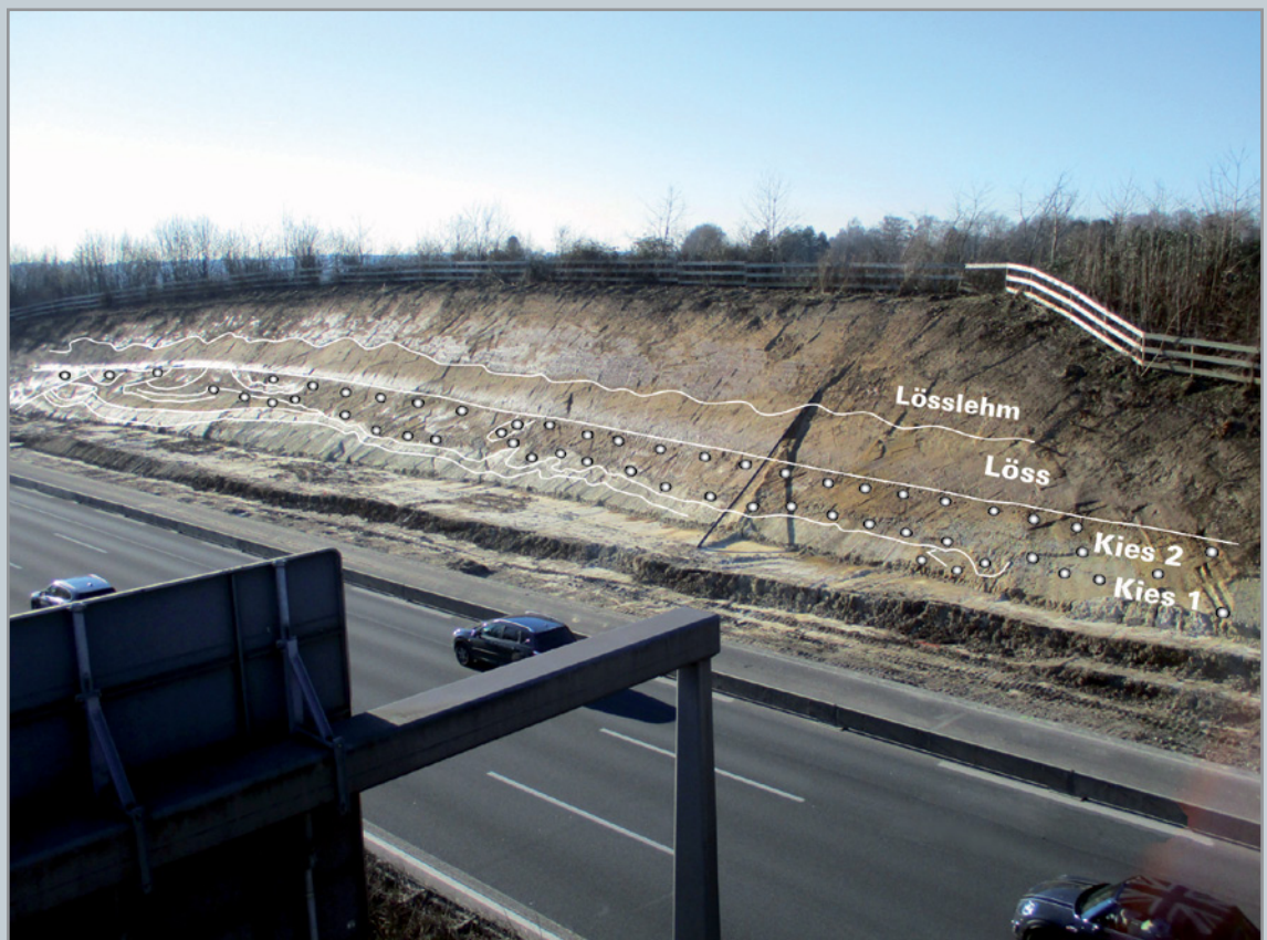
Abb. 3: Gesamtansicht der Westböschung der A 3 und der generalisierten Schichtenfolge, gesehen von der Brücke Altenbrachtweg mit Blick nach Süden
