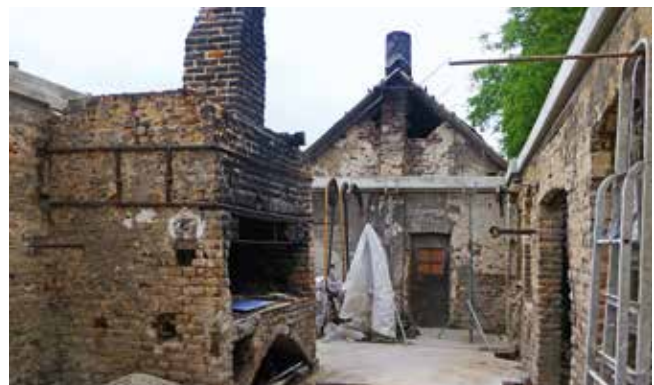
Unten: Umbauphase ohne Dach, im Vordergrund der Schmiedeherd.
