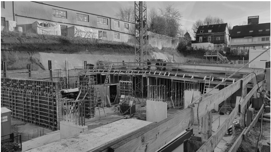
Alte Dorfstraße: Blick auf die I.D.G.-Baustelle in Richtung Osten.
