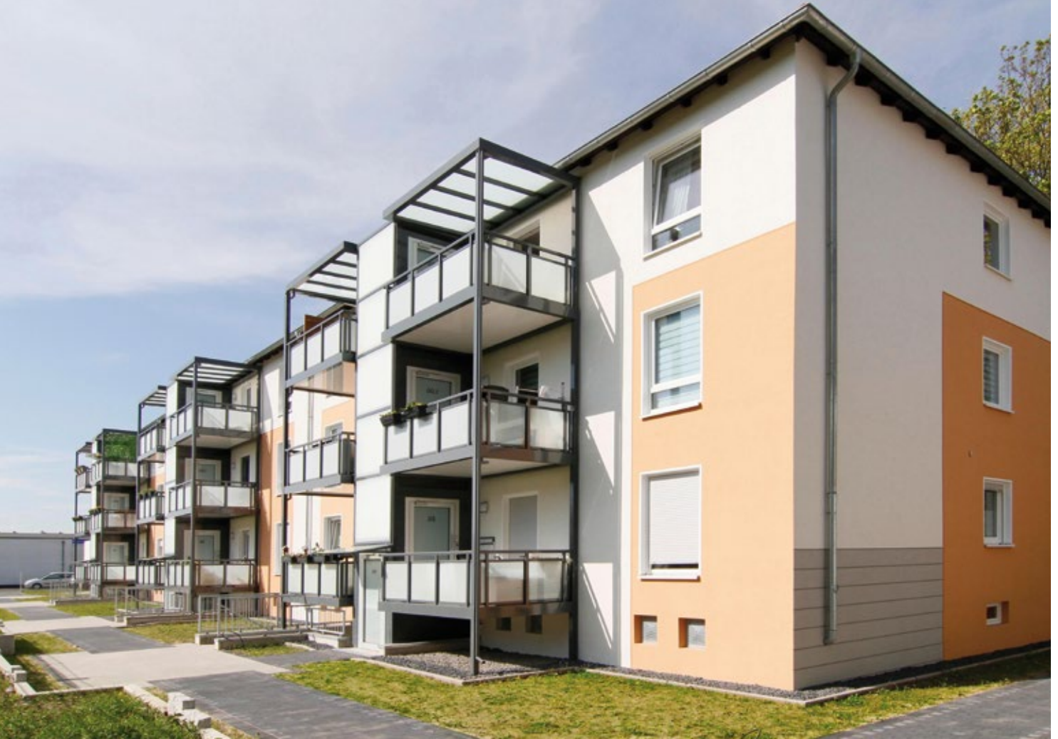
Modernisierungsbeispiel Duisburg, Kaufstraße Durch einen Balkonanbau mit integrierter Aufzugsanlage wurde ergänzend zur vorhandenen Erschließung ein barrierefreier Zugang geschaffen.
