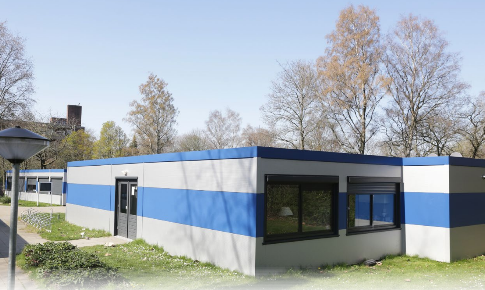
Die hergerichtete Quarantänestation an der Blanckertzstraße
