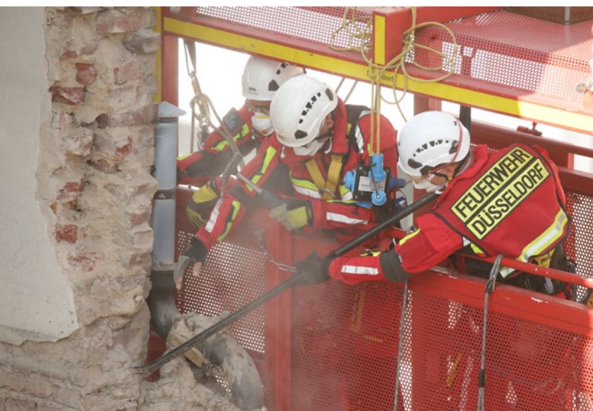
Vorsichtige Abbrucharbeiten aus dem PAM.
