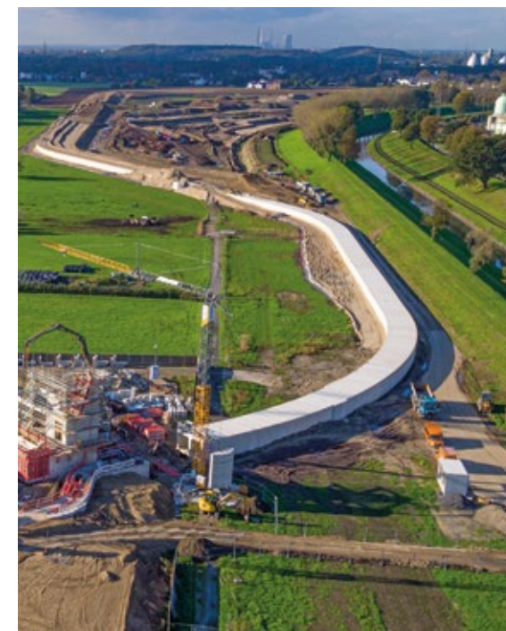
24 Abwasserkanal Emscher Arbeiten laufen unter Hochdruck weiter
