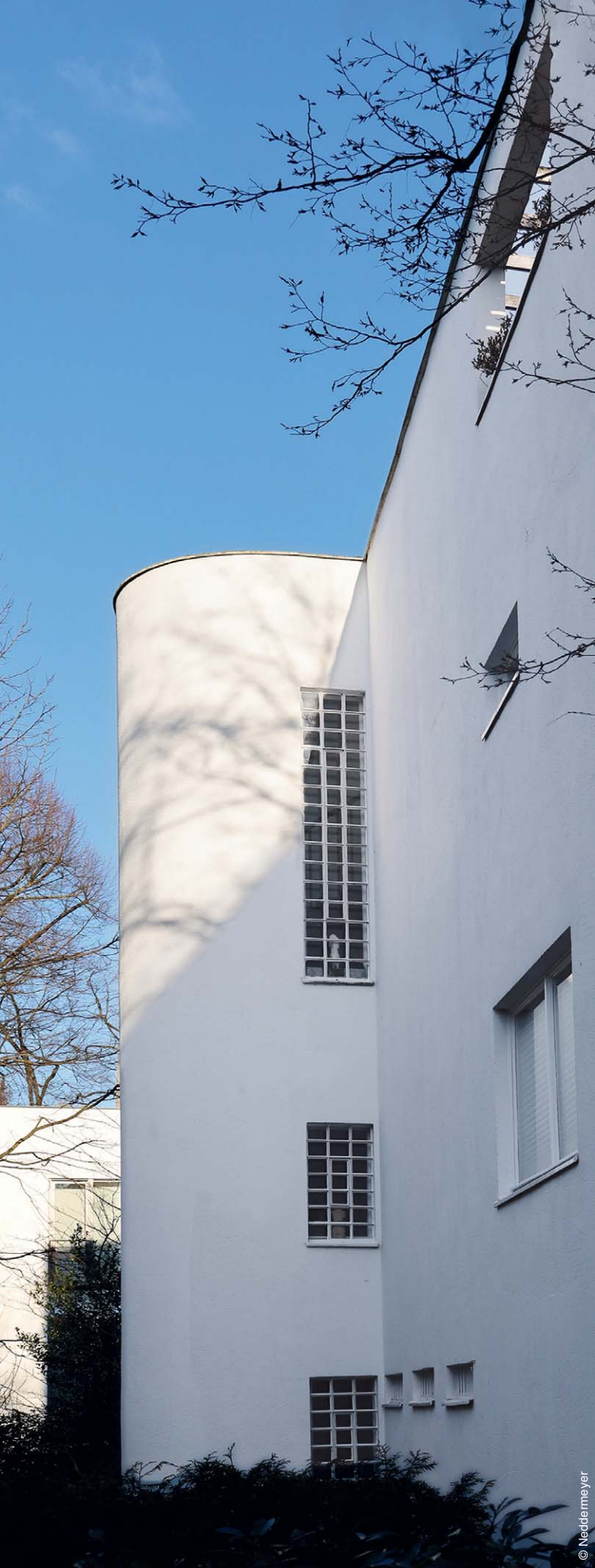
Das Haus Prof. Hussmann, Im Park 2, wurde 1930 nach Entwürfen von Hans Schumacher binnen nur vier Monaten gebaut.
