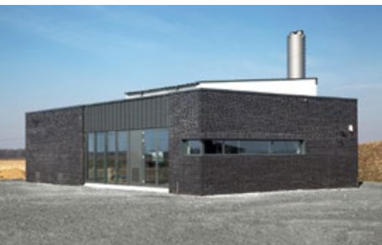
Die Heizzentrale ist über das 4,6 Kilometer lange Rohrleitungssystem mit dem Neubaugebiet verbunden.
