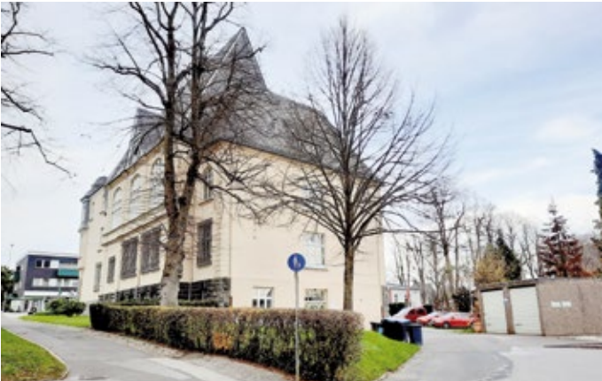
Die Bauarbeiten hinter dem Rathaus Lüttringhausen können beginnen.
