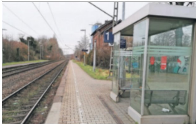
Zugegeben: Einladend ist anders. Der Bahnhof Jüchen wurde mit „nicht tolerierbaren Zuständen“ bewertet. Fotos: Julia Schäfer
