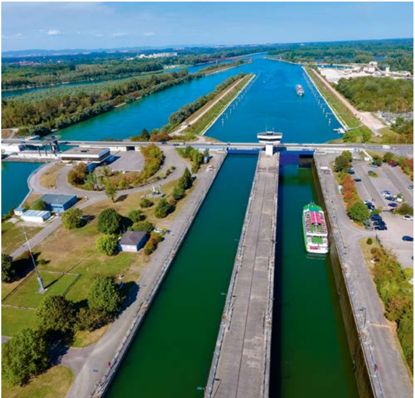
Wasserkraftwerk und Staustufe Iffezheim
