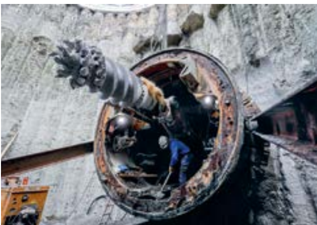
Neubau eines Abwasserkanals an der Berne, einem Nebenfluss der Emscher, Einfahrt der Tunnelbohrmaschine in den Zielschacht: Die Berne, vorher ein offener, oberirdischer Schmutzwasserkanal mit Oberflächenwasser und Abwasser, wird renaturiert und zu einem naturnahen Gewässer umgestaltet.
