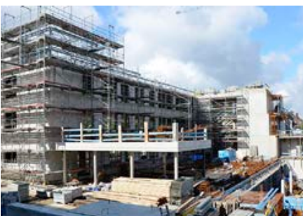
Der Bauboom sorgt für Wirtschaftswachstum.
