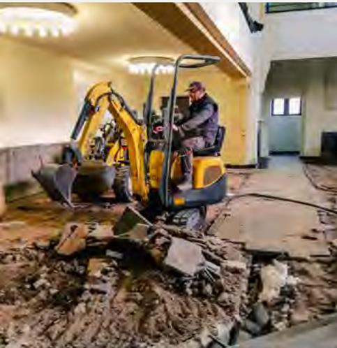
**I**m Zuge der Umgestaltung der Graf Recke Kirche zum geistlichen Zentrum der Graf Recke Stiftung wird jetzt ein neuer Boden mit Fußbodenheizung in die Kirche eingebaut. Anstelle der Bänke wird im Anschluss eine flexible Bestuhlung eingesetzt, die auch bei Tagungen und Seminaren genutzt werden kann. Die Kirchenbänke wurden an andere Kirchengemeinden, Institutionen und auch Privatpersonen abgegeben. Auch nach Fertigstellung bleibt die Graf Recke Kirche der Gottesdienstort für die Stiftung.
