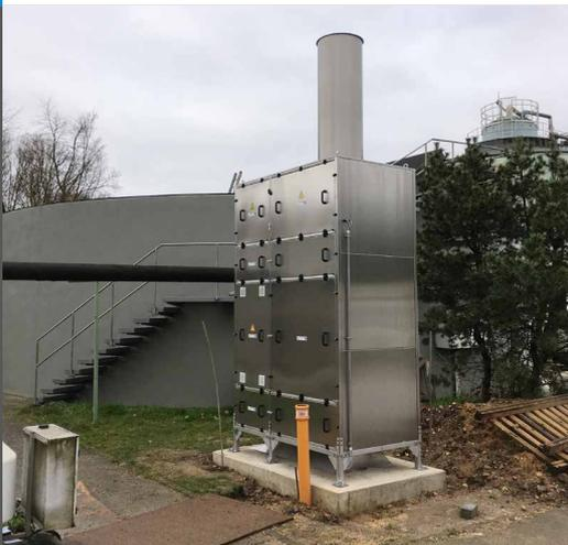
Abluftreinigungssystem für entstehende Gase unter der Abdeckung
