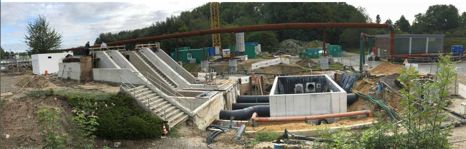
Umbau des Schneckenhebewerkes und Neubau des Verteilerbauwerkes
