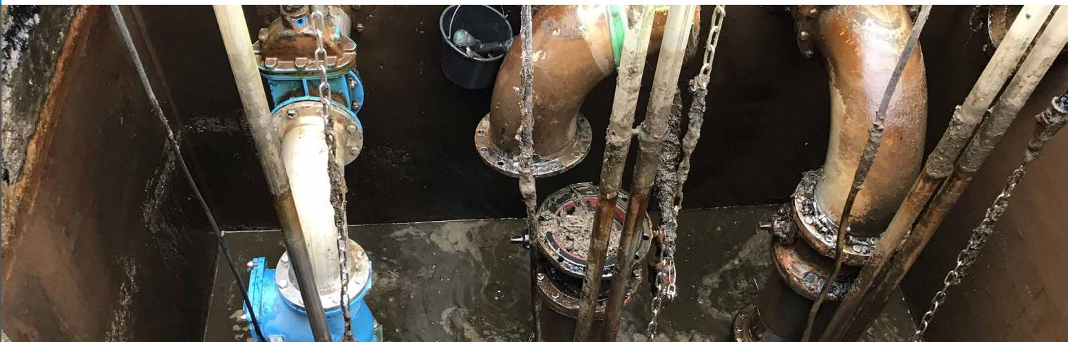
Kugelrückschlagventile (links) ersetzen die häufig verstopften Rückschlagklappen (rechts) der Biologie (Straße 1) auf der Kläranlage Grefrath.
