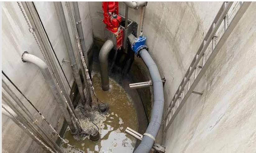
Zerkleinerungsaggregat samt zuführender Rohrleitung
