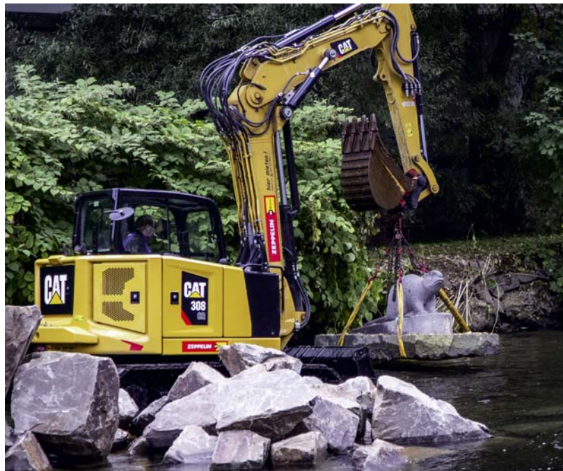
Der Biber wird eingebaut.
