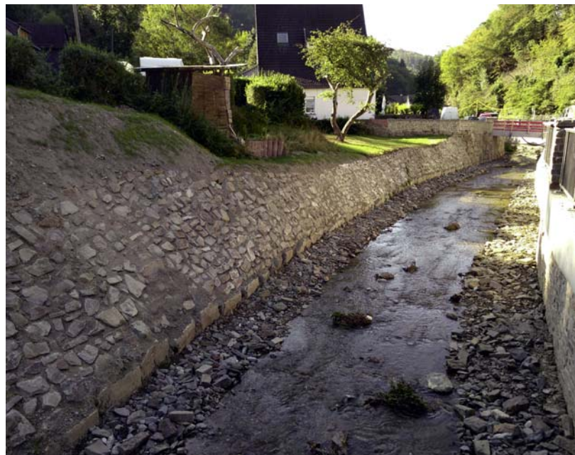
neue Ufermauern am Eschbach
