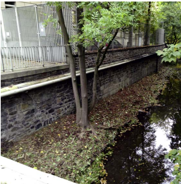
Ufermauer im Bereich Gerichtsinsel in Wuppertal
