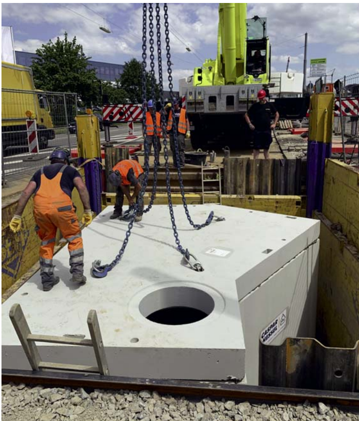
Schachteinbau an der Schwelme
