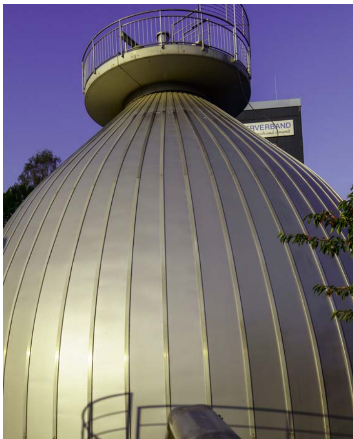
Faulbehälter Kläranlage Hückeswagen
