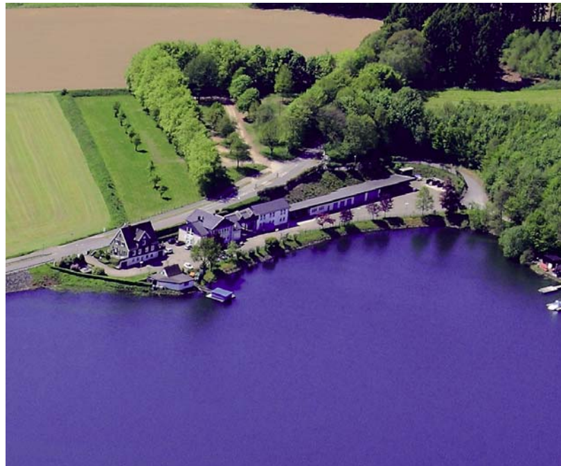
Betriebsgelände an der Bever-Talsperre
