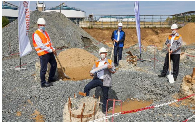
Grundsteinlegung am 13.08.2020 in Leverkusen
