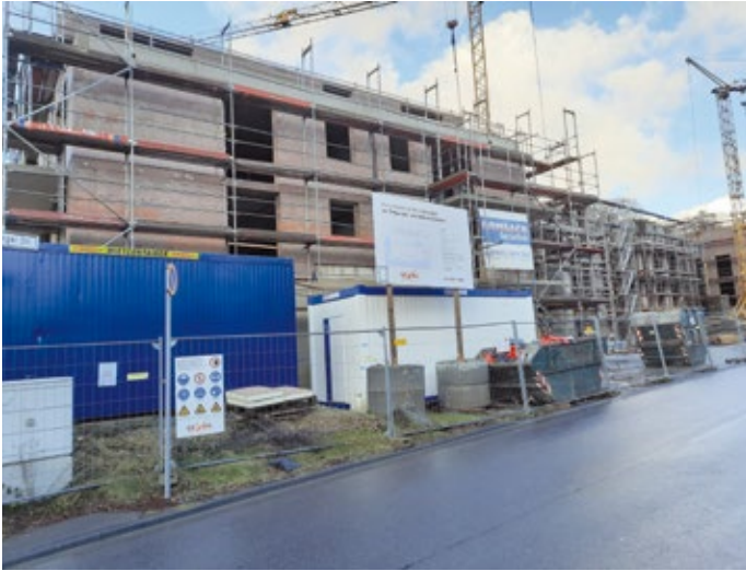
Es geht voran an der Hackenberger Straße. Die Gewag lässt hier modernen Wohnraum entstehen.
