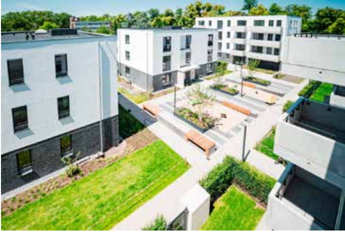
An der Nordkanalallee sind schon Mieter eingezogen
