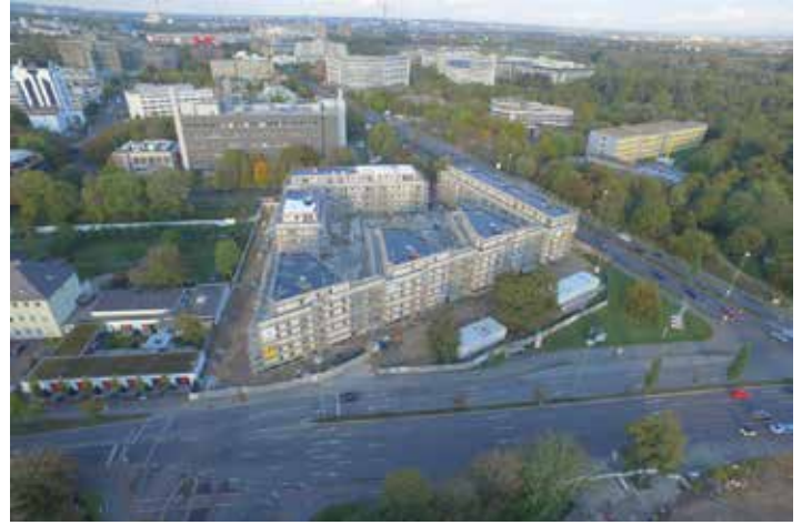
Auf dem Leuchtenberg-Gelände ist der Rohbau fertiggestellt
