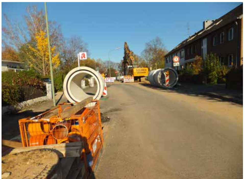
Bei Kanalbauarbeiten am Grüner Weg wurden Überreste römischer Siedlungsstrukturen gefunden
