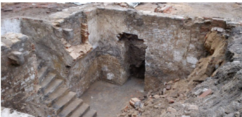
Abb. 4: Kellergewölbe des Mercatorhauses
