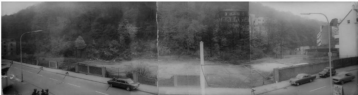
Quelle: Agentur für Arbeit Solingen-Wuppertal, Baugelände aus dem Bautagebuch
