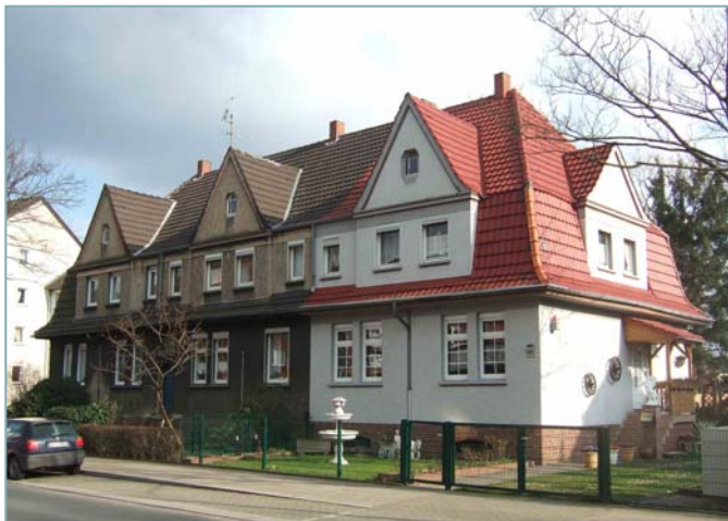
Foto 7: Sanierungsmaßnahme in Bochohd/Altendorf
