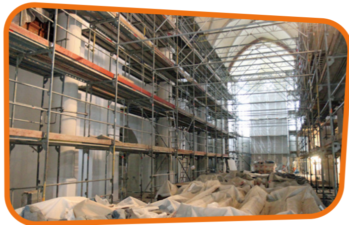
Ein Eindruck von der Sanierung der Grevenbroicher Pfarrkirche St. Peter und Paul ist auf dem Titel des neuen „Jahrbuchs für den Rhein-Kreis Neuss 2021“ zu sehen. © T. Zimmermann
