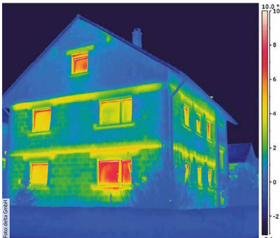
Infrarotbild eines Wohnhauses
