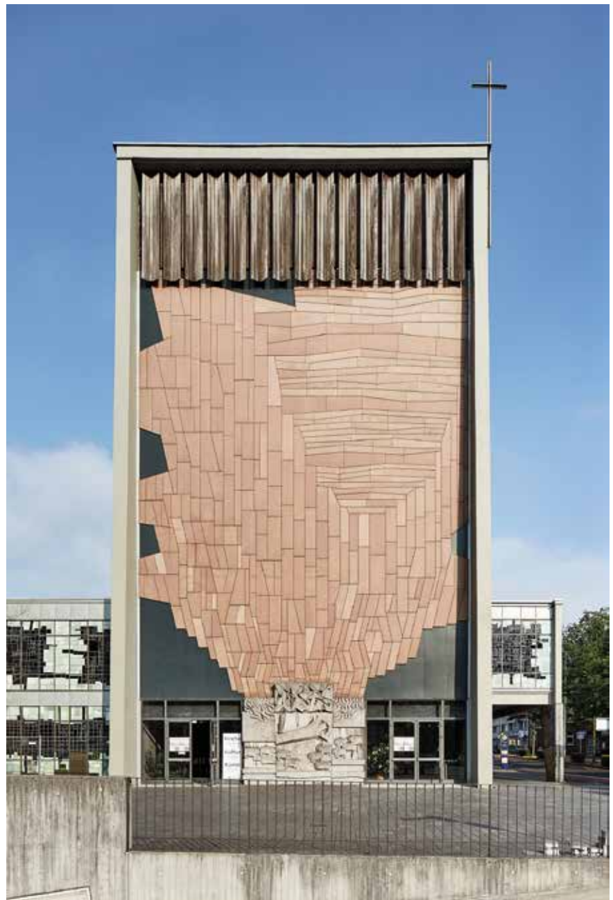
Umnutzung der denkmalgeschützten Liebfrauenkirche in Duisburg zu einer Kulturkirche.
