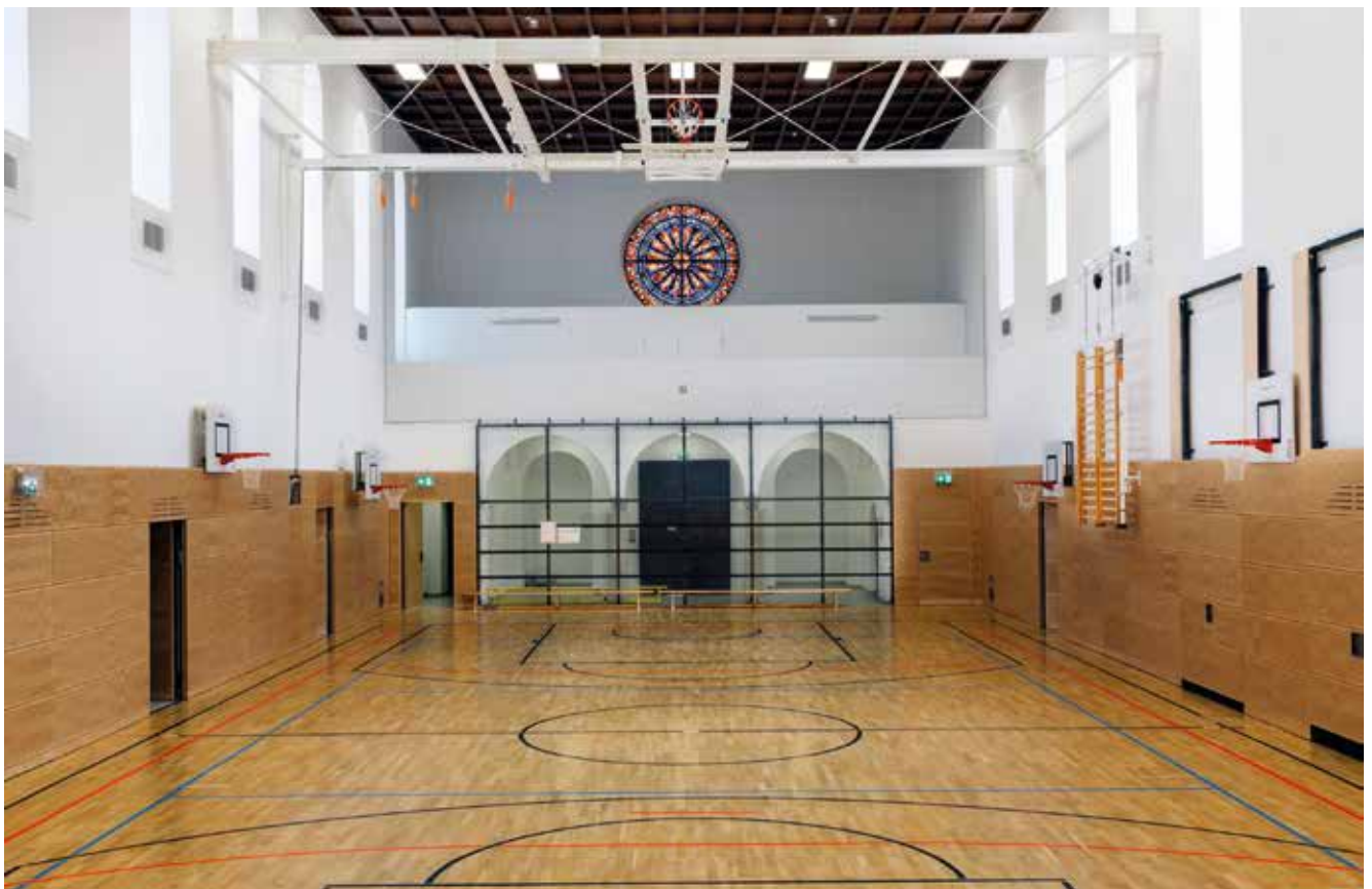
Umbau der St. Elisabethkirche in Münster zu einer Schul-Turnhalle mit einem angrenzenden Neubau zweier Wohnhäuser.
