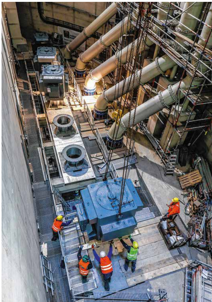
Einsetzen der Motoren im Pumpwerk Oberhausen.
