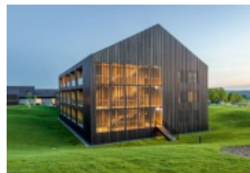
Ausgezeichnet: Von außen kaum erkennbar, lassen es manche Fassadenelemente zu, dass man hindurchschauen kann.
