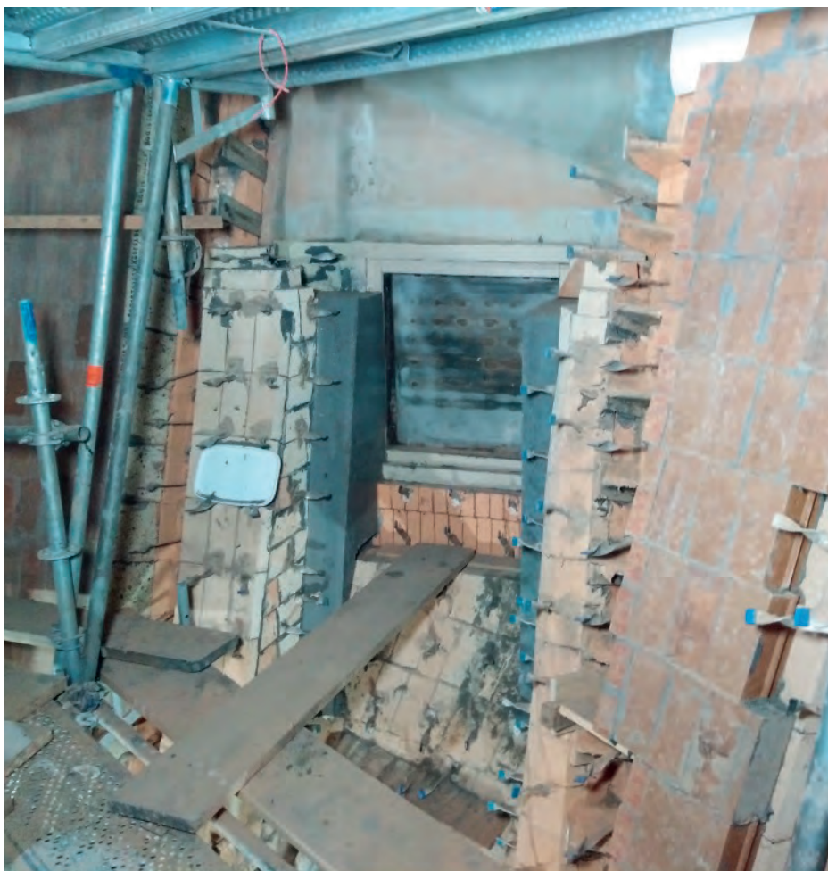
Die Ausmauerung und die Stahlhaut des Ofens wurden bei der umfassenden Sanierung zu Jahresbeginn 2019 komplett erneuert.
