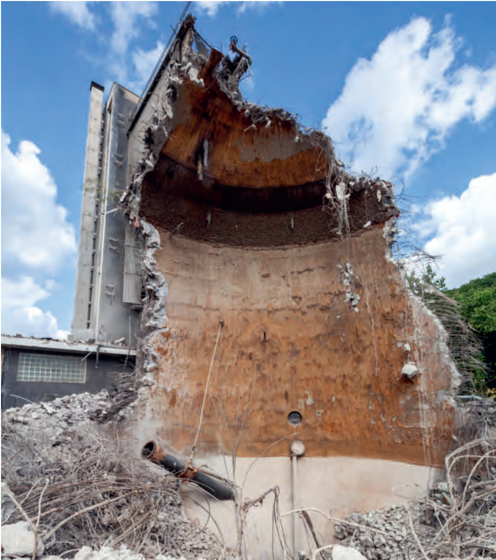
Auf dem Gelände der ehemaligen Kläranlage Witten-Heven wurden im Jahr 2019 die letzten Gebäudeteile abgerissen.
