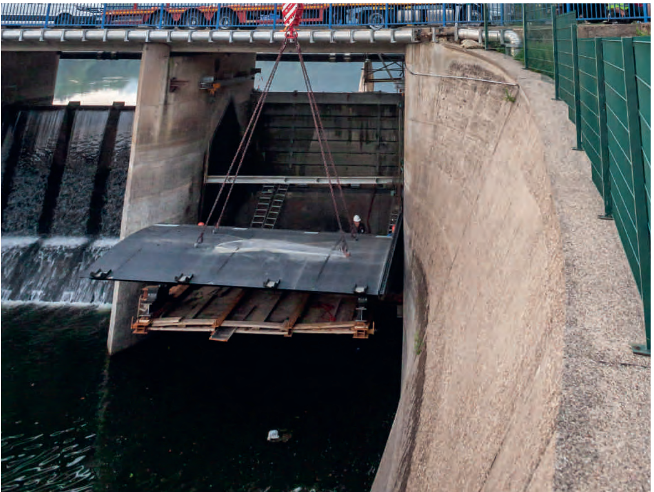
Die neue Fischbauchklappe im linken Wehrfeld des Vordamms Eichhagen wurde im September 2019 eingebaut.
