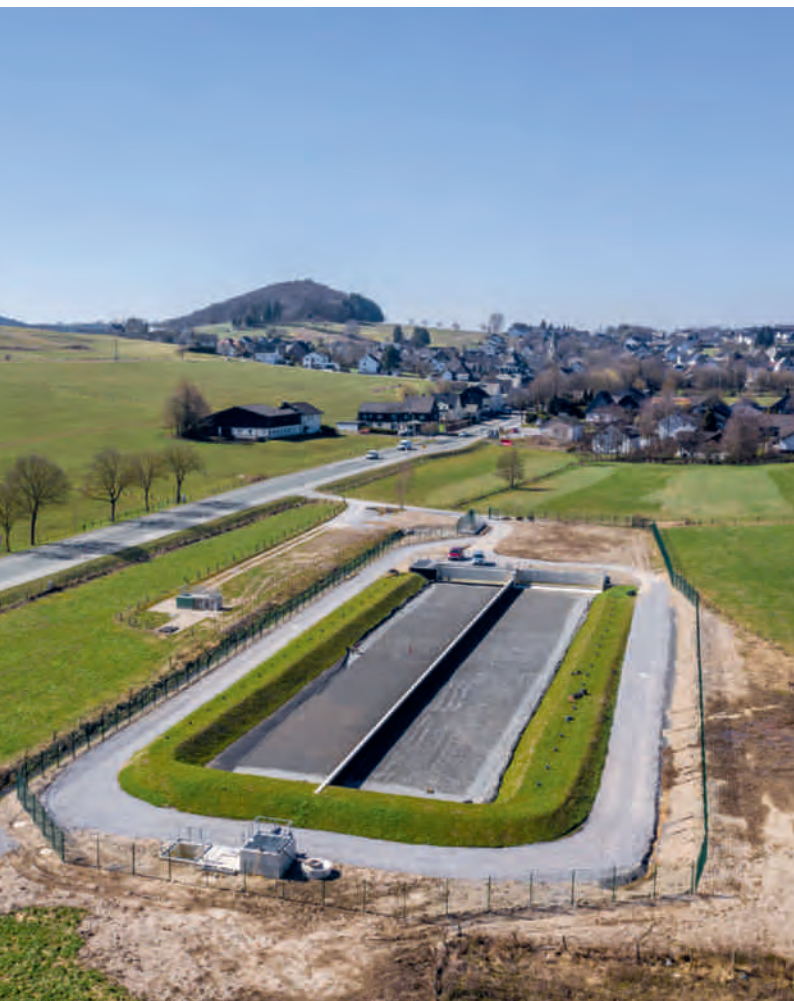
Die Arbeiten am Retentionsbodenfilter des Stauraumkanals Brilon-Altenbüren (l., Foto Andreas Weller/Olsberg) wurden im Herbst 2019 abgeschlossen, die Bepflanzung mit rund 11.000 Schilfpflänzchen (r.) folgte im Frühjahr 2020.
