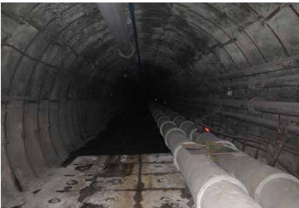
**Bild 9.2** – Rohrleitungstrasse im Förderberg
