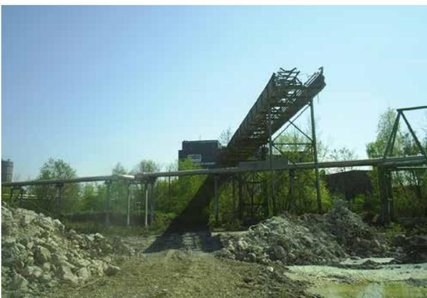
**Bild 13.1** – Blick auf die zum Teil zurückgebaute Bandbrücke zwischen der Schachtanlage und der Bergeverladung Prosper II
