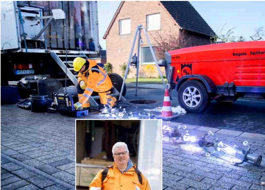
Die Lichterkette wird nach dem Aufstellen durch den Inliner gezogen und härtet ihn mit UV-Licht aus.
