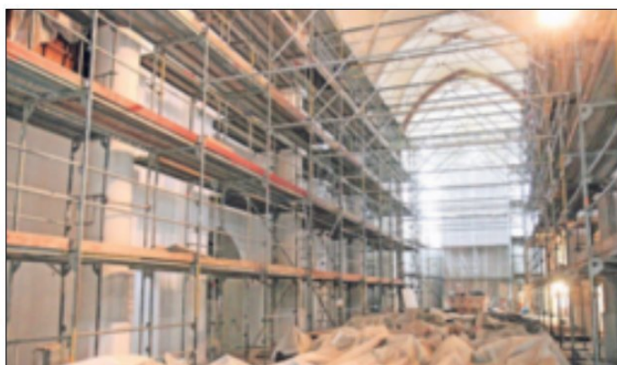
Ein Eindruck von der Sanierung der Grevenbroicher Pfarrkirche St. Peter und Paul ist auf dem Titel des neuen „Jahrbuchs für den Rhein-Kreis Neuss 2021“ zu sehen.
