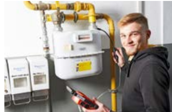
Marco Harth (l.) und Ernst Zej (r.) werden bei den Stadtwerken Ratingen zu Anlagenmechanikern für Versorgungstechnik, Fachrichtung Rohrsystemtechnik, ausgebildet. Marco Harth (Foto rechts) überprüft nach dem Wechsel von Verschraubungen an einem Gaszähler deren Dichtigkeit.
