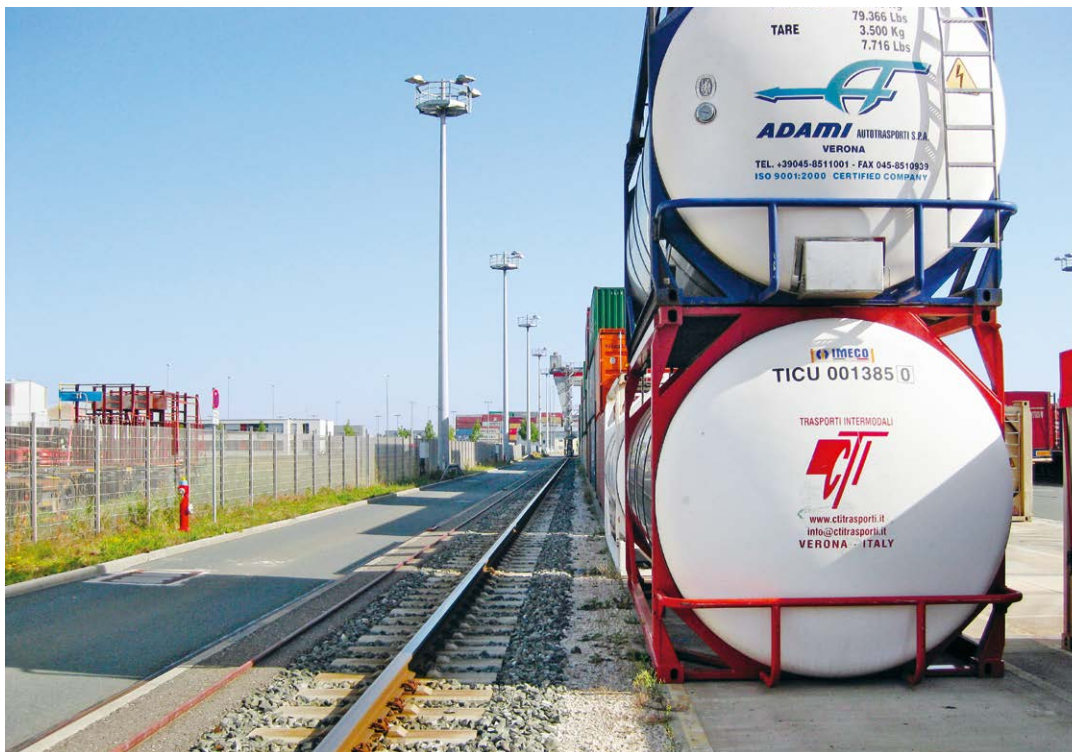
Ungünstige Abstellpositionen am freien Plattenrand und mit Containerfüßen im Fugenbereich
