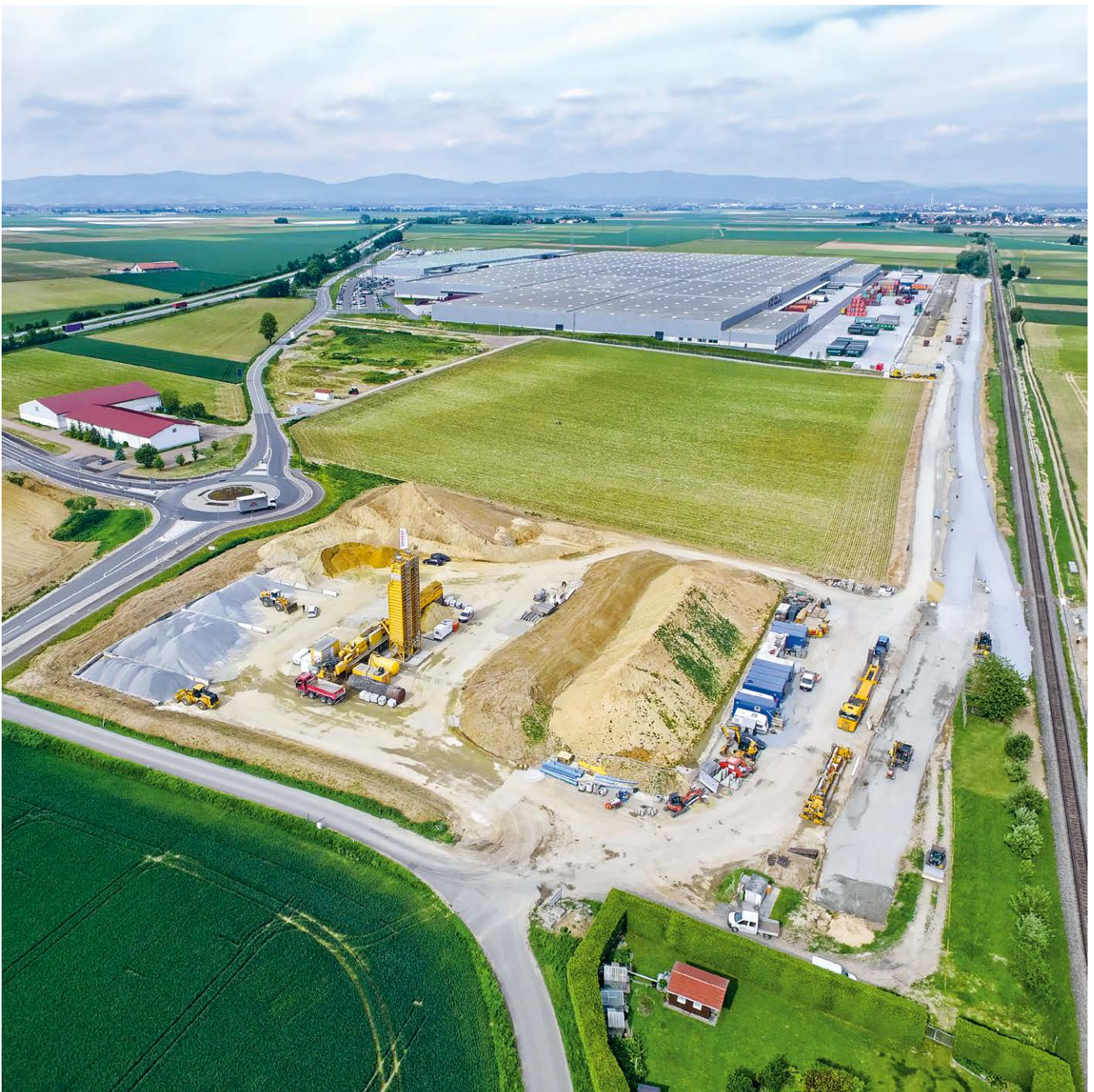
Baustelle BMW-Logistikzentrum Wallersdorf mit Betonmischanlage im Vordergrund und Baufeld im Hintergrund
