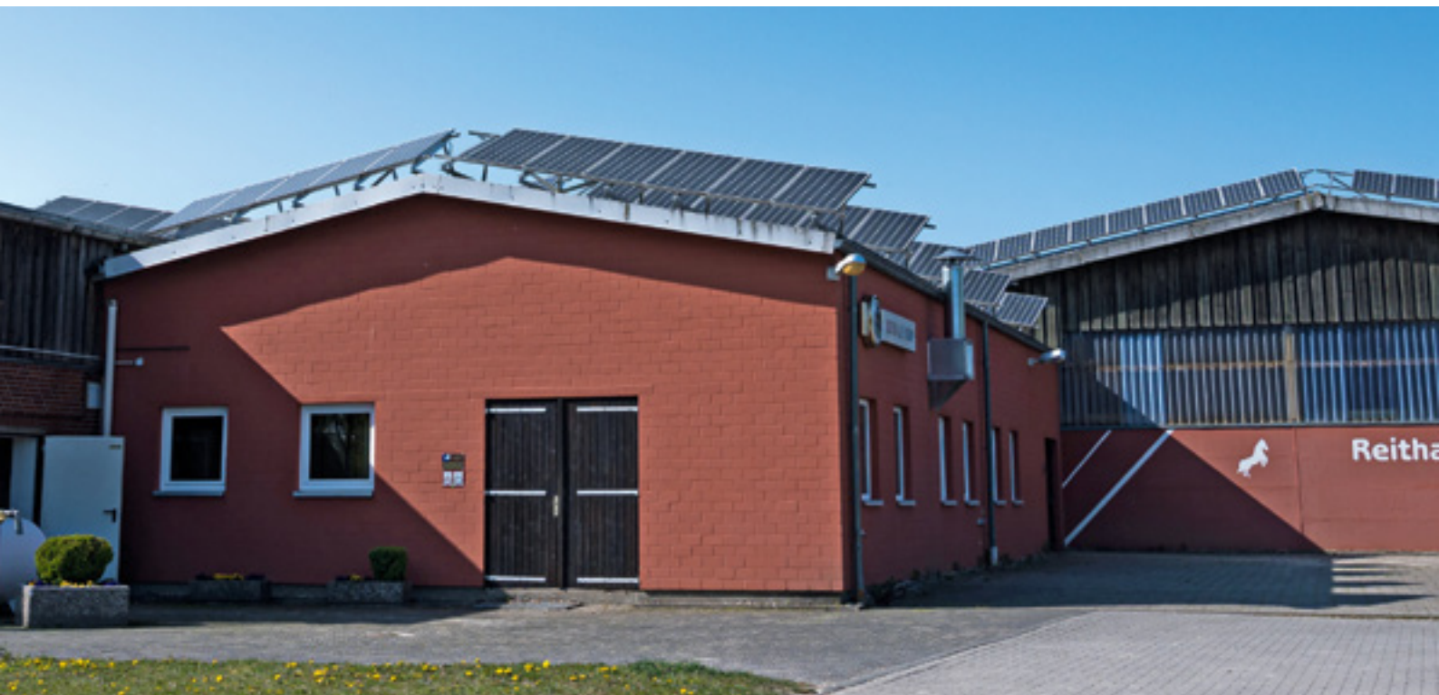
Der Clubraum des Zucht-, Reit- und Fahrvereins Legden wird energetisch saniert, modernisiert und zu einem Medien- und Schulungsraum umgebaut
