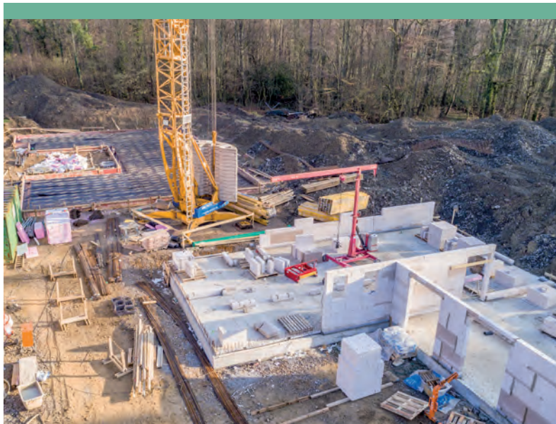
Der erste Bauabschnitt ging schnell vorbei.
