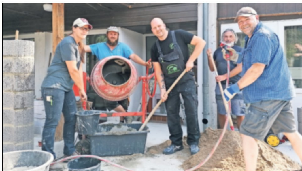
Seit Juni packt das Ehrenamtler-Team fleißig an, um den Katzen ein schönes Außengelände zu bauen. Dabei muss alles auf Maß gebaut werden.
